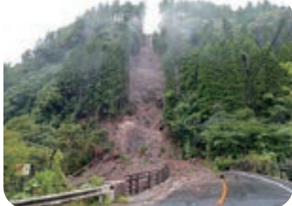
大雨による土砂災害の現場(国道223号)
